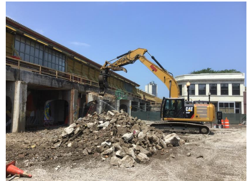
W Bryn Mawr viaduct
